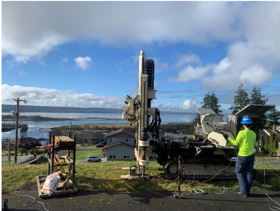
Figura 12. Unidad de perforación pequeña con anclaje
